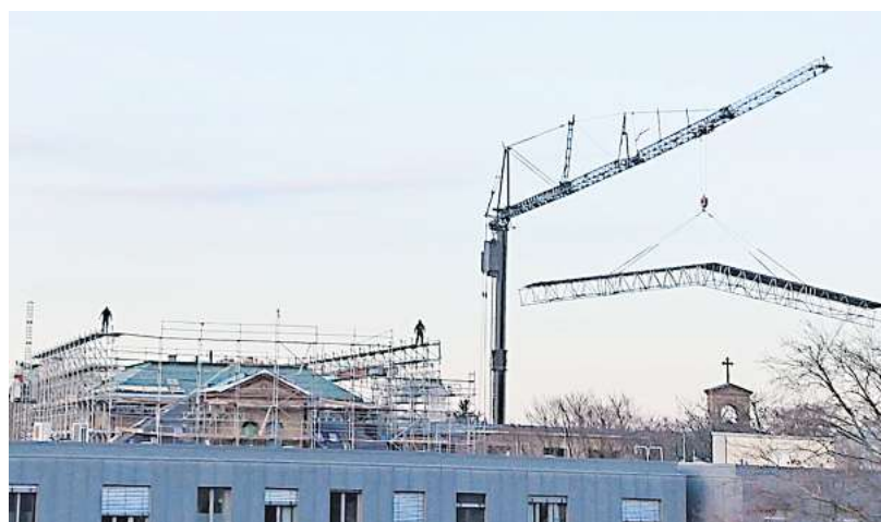
Die Bauarbeiten am historischen Josefs-Haus erreichen eine neue Phase: Ein Kran hebt das Wetterschutzdach Stück für Stück ab. FOTO: NADINE FABIAN
